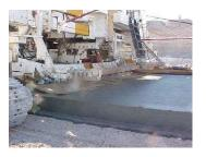
Figure 6-409.3. Slipform PCCP Paver.
